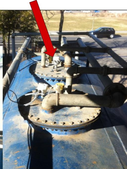
Высокоточные помехозащищенные волновые датчики уровня любых видов топлива и масла для промышленных емкостей (высота до 20 м). Обеспечивают непрерывное измерение в резервуарах сложной геометрии. Устройства поставляются в корпусе IP68 и соответствуют европейскому стандарту взрывозащиты ATEX. Отличаются простотой при установке и тарировке.
